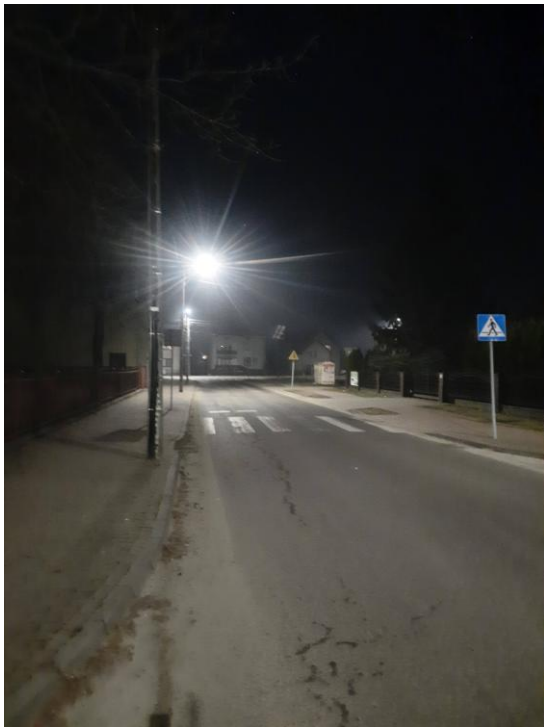
Zdjęcie 11: Oświetlenie przejścia przy ul. Sienkiewicza (przy ul. Wiejskiej). Źródło: własne.
