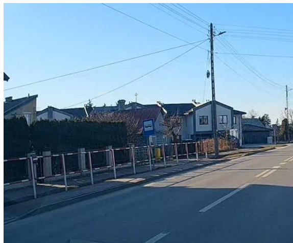
Zdjęcie 45: Brak linii przystankowej P-17. Źródło: własne.
