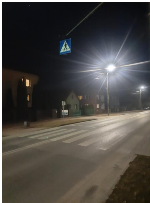
Zdjęcie 8: Oświetlenie przejścia przy ul. Warszawskiej. Źródło: własne.
