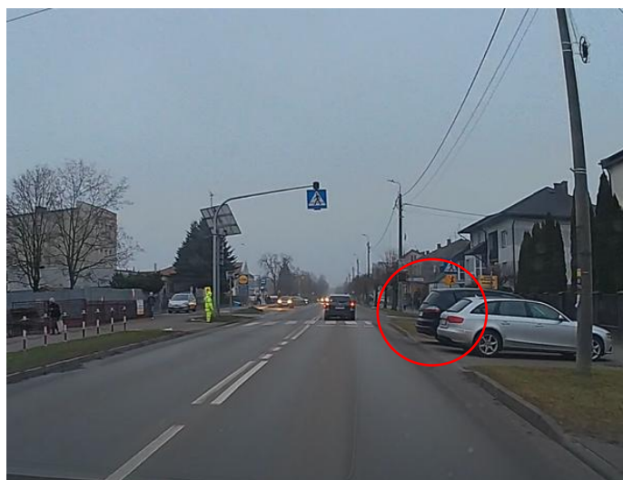
Zdjęcie 55: Przesłanianie strefy oczekiwania przez pojazd osobowy. Przy zatrzymaniu wyższego pojazdu np. busa, strefa oczekiwania będzie całkiem przesłonięta.
