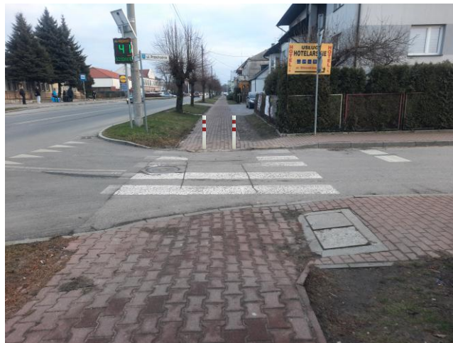
Zdjęcie 5: Widok na drogę dla pieszych wykorzystywaną jako wyjazd spod sklepu – propozycja wykorzystania słupków blokujących do uniemożliwienia przejazdu pojazdów. Źródło: własne.
