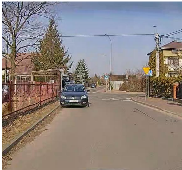
Zdjęcie 17: Widok od strony ul. Pocztovej na ul. Wiejską – słabo dostrzegalne skrzyżowanie oraz przejście dla pieszych, bez ograniczenia prędkości, dodatkowo występuje postój pojazdów w sposób przesłaniający widoczność na pieszego w strefie oczekiwania.
