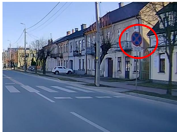
Zdjęcie 23: Brak czytelności tabliczki pod tarczą znaku B-36 oraz błędna lokalizacja. Źródło: własne.
