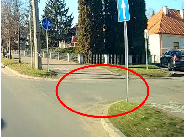
Zdjęcie 19: Brak oznakowania poziomego i pionowego przejazdu pieszo -rowerowego na skrzyżowaniu z ul. Pocztową Źródło: własne.
