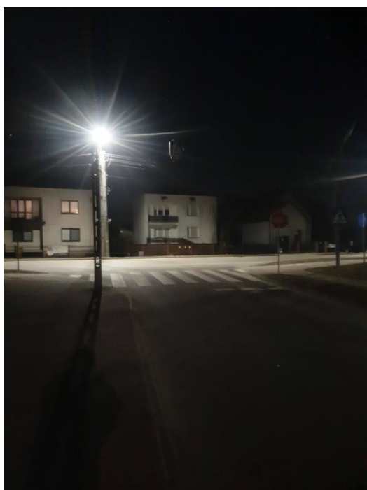
Zdjęcie 9: Oświetlenie przejścia przy ul. Sienkiewicza (przy ul. Warszawskiej). Źródło: własne.
