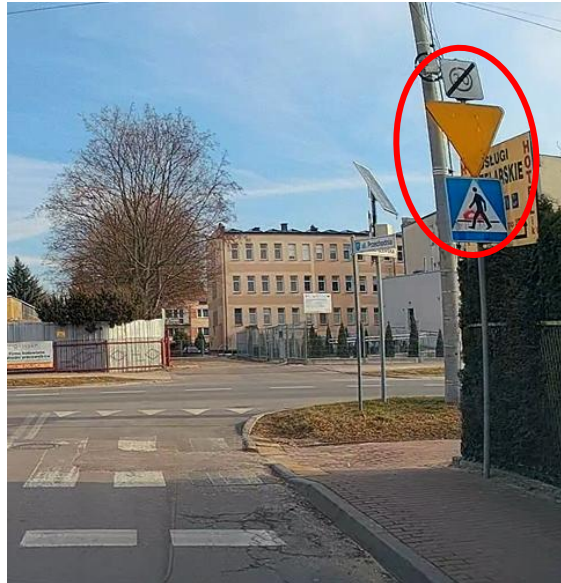
Zdjęcie 40: Zabrudzona tarcza znaku D-6 „Przejście dla pieszych” Zużyta tarcza znaku A-7 oraz nieprawidłowe zestawienie tarcz znaków. Źródło: własne.
